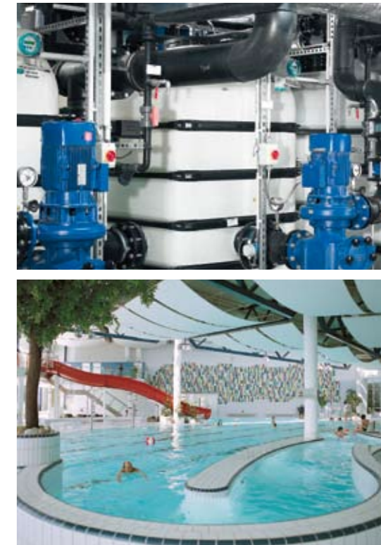
In Schwimmbädern werden WERIT Industrietanks z.B. als Schwallwasserbehälter eingesetzt (siehe Abbildung oben, Betriebsraum des Schwimmbades Maximare in Hamm/ Westfalen). WERIT industrial tanks are used in swimming pools as tanks for splash water, for example (see illustration on above, machine room of the Maximare swimming pool in Hamm / Germany).
